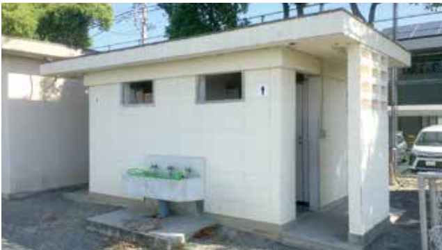
二本木小学校の屋外トイレ
