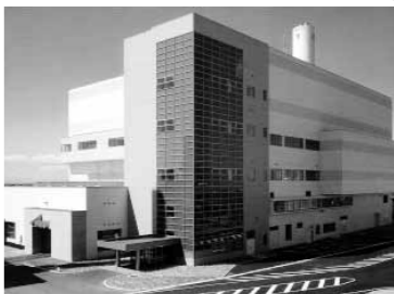
ごみ焼却施設
