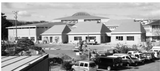
建設中の明祥地域複合施設
