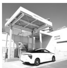
水素ステーション
