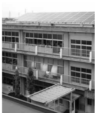
校舎屋上の太陽光パネル
