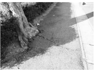
木の根で盛り上がった歩道
