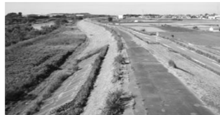
矢作川堤防工事の予定箇所(小川町)
