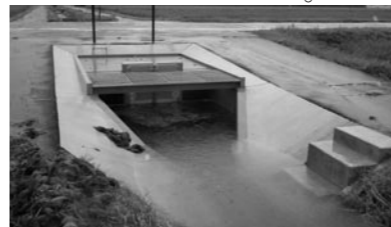
雨水の流量を調整するマス
