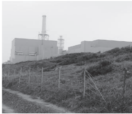
浜岡原子力発電所
