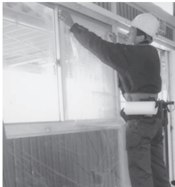
飛散防止フィルム貼り付け工事
