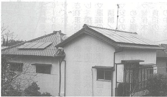
▲導入促進のため設置者に報奨金が出ることになった太陽光発電システム
