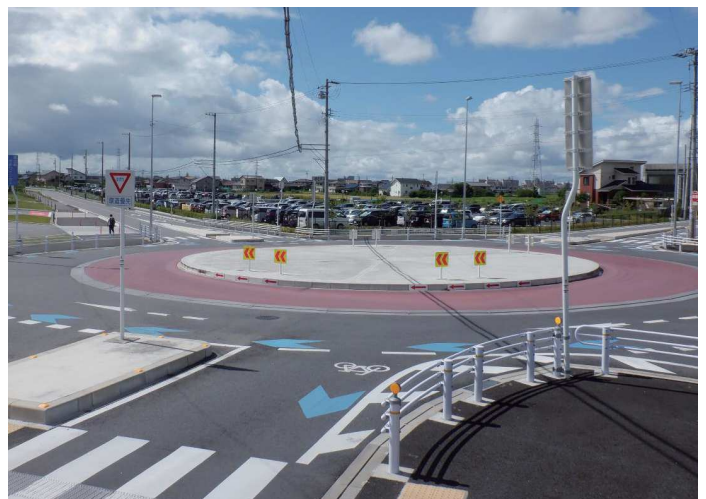
安全性向上に向けた交差点改良（ラウンドアバウト *5 ）
